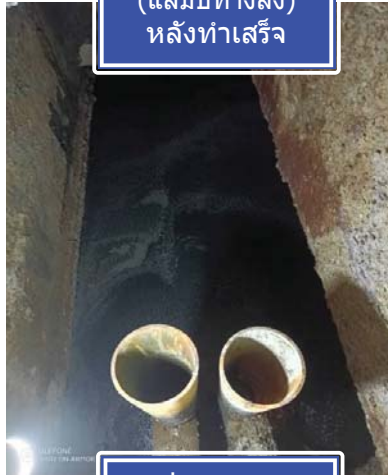
บ่อเกรอะ (แลมปีทางลง) หลังทำเสร็จ
