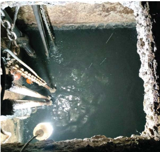
บ่อ SUMP PUMP (ชั้น B 1) หลังทำเสร็จ
