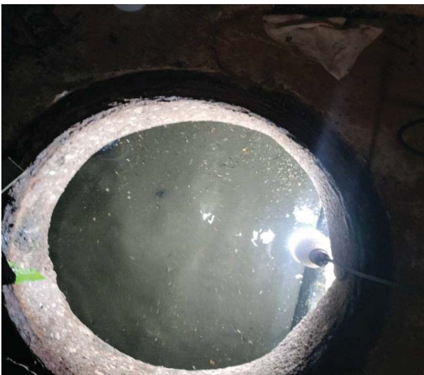
บ่อเกรอะ(Septic) (ชั้น B 2) หลังทำเสร็จ
